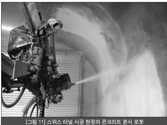
[그림 11] 스위스 터널 시공 현장의 콘크리트 분사 로봇
